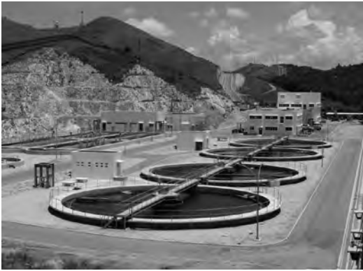
写真-3 ポートモレスビーの下水処理場
